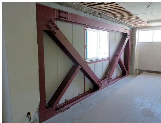
RCの建物の補強ブレース設置
