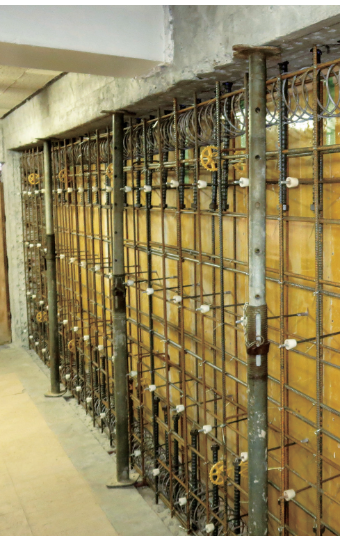
RCの建物の補強ブレース設置
