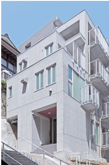
横浜台町新築斜面中腹に立つ共同住宅
