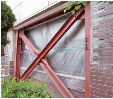
鉄骨の建物の補強ブレース設置
